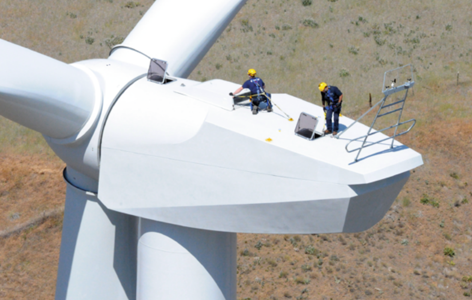
Servicearbeiten auf der Gondel einer Windenergieanlage Maintenance on a wind turbine nacelle
