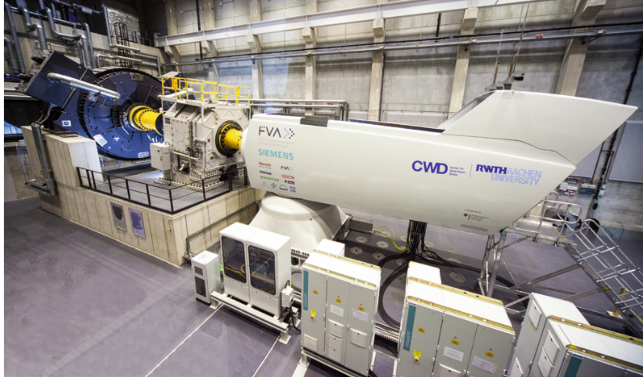
4 MW-Systemprüfstand/4 MW system test bench
